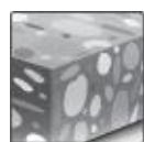
Бетон (без трещин)
